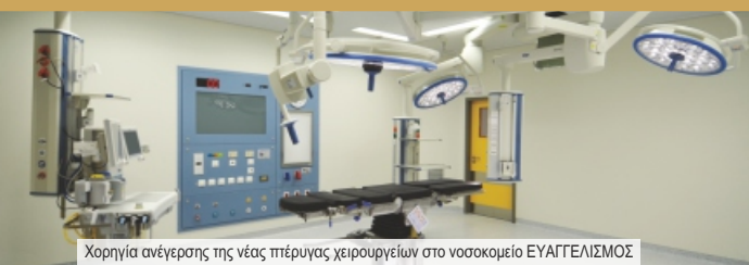
Χορηγία ανέγερσης της νέας πτέρυγας χειρουργείων στο νοσοκομείο ΕΥΑΓΓΕΛΙΣΜΟΣ
