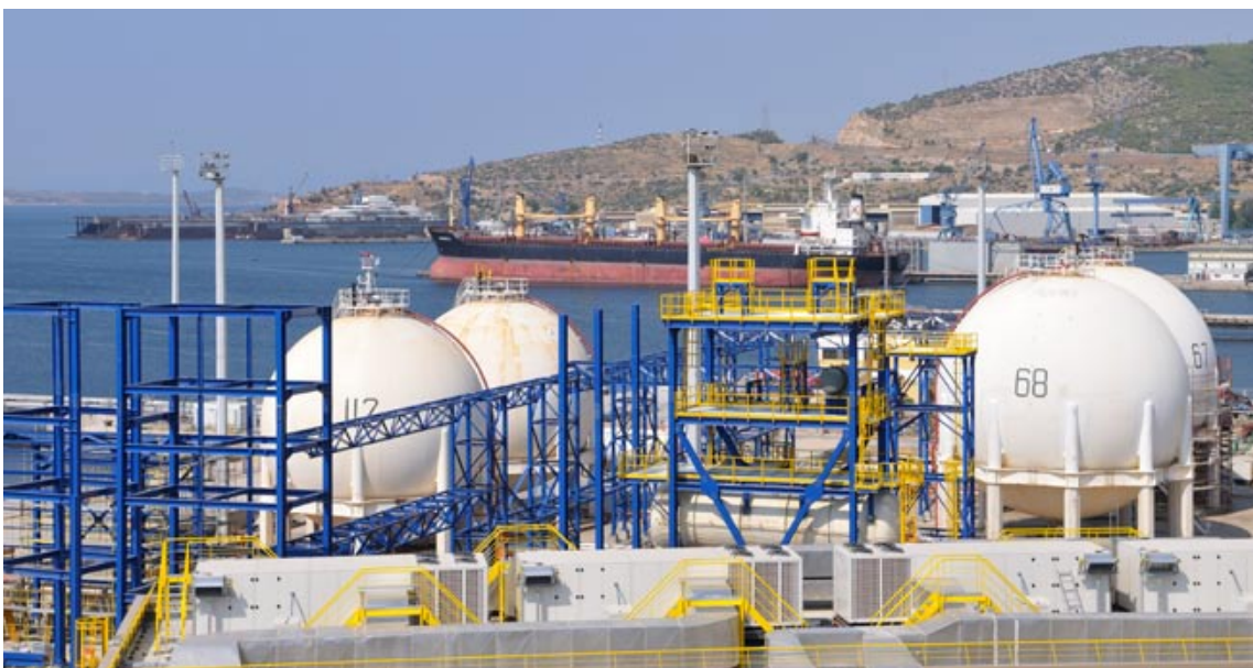
Εγκαταστάσεις Διυλιστηρίου Ελευσίνας
