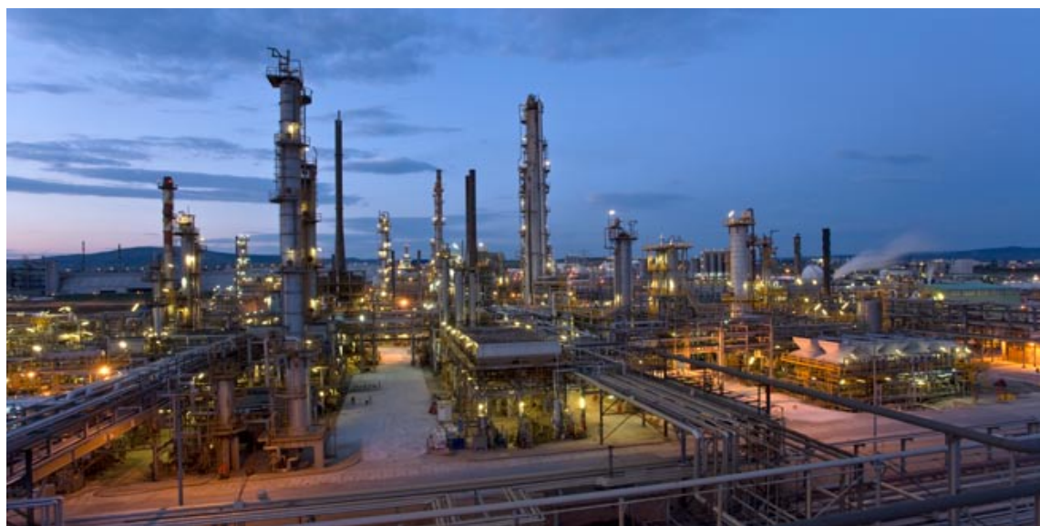
Άποψη του Διυλιστηρίου Θεσσαλονίκης
