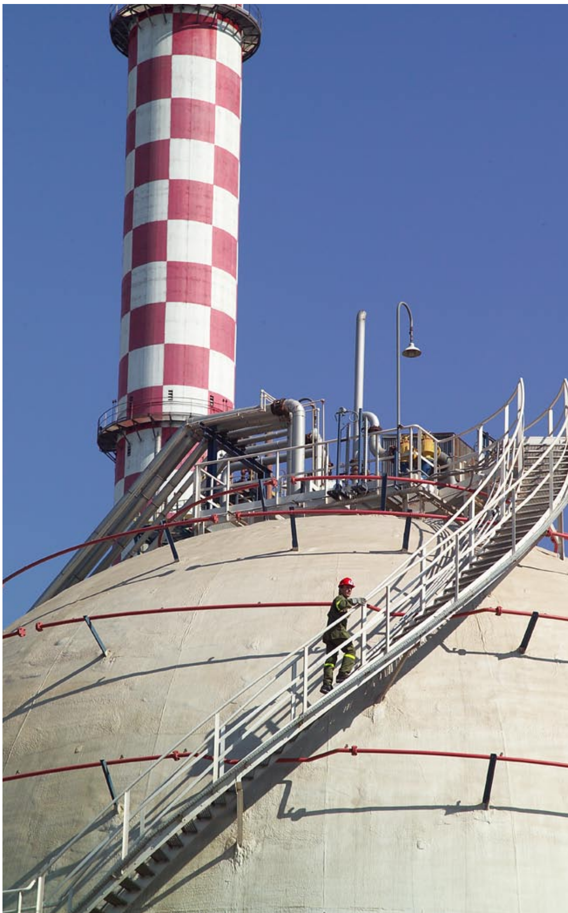
Δεξαμενή Αποθήκευσης Προϊόντος στις ΒΕΑ
