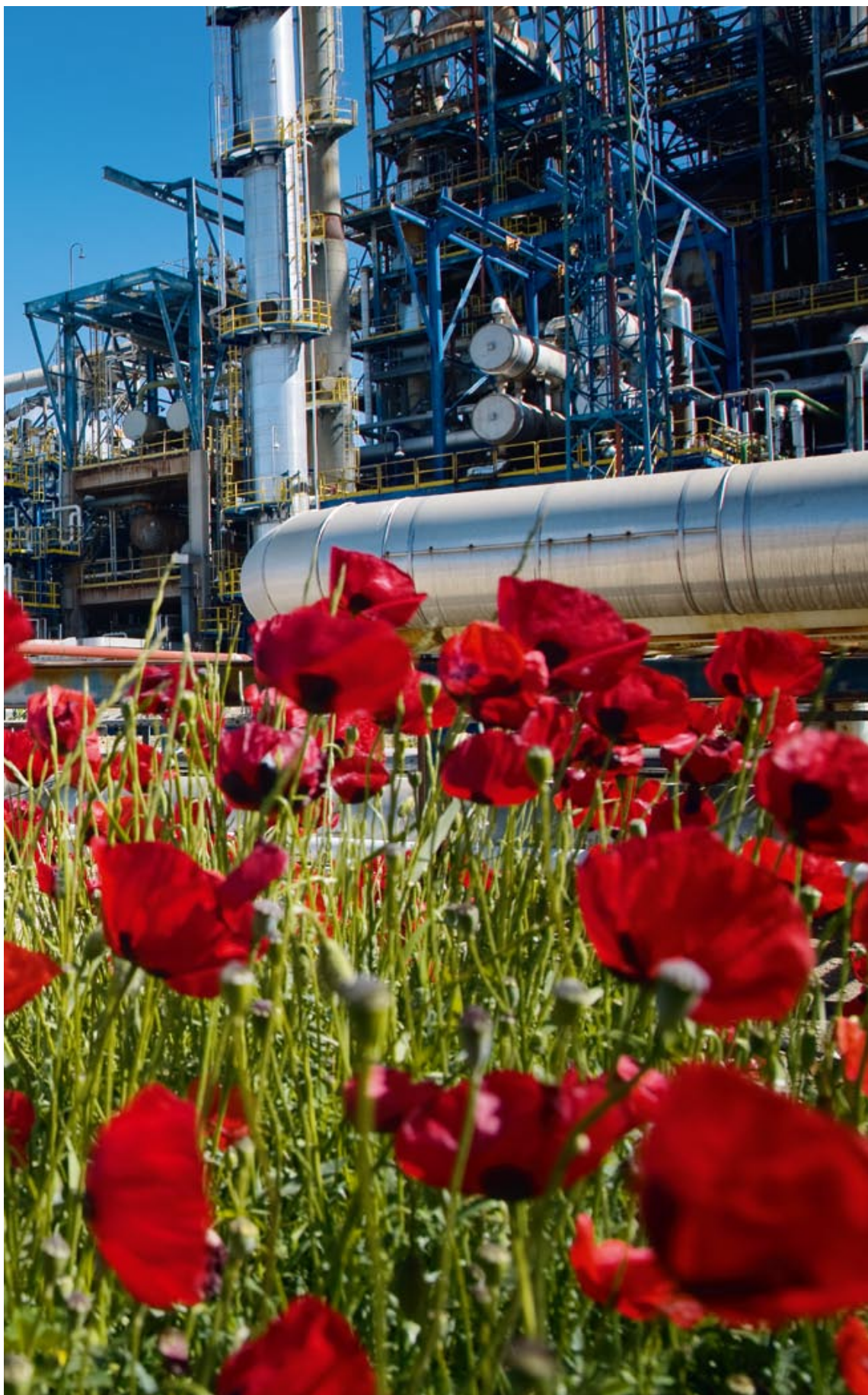
Άποψη διυλιστηρίου Ασπροπύργου
