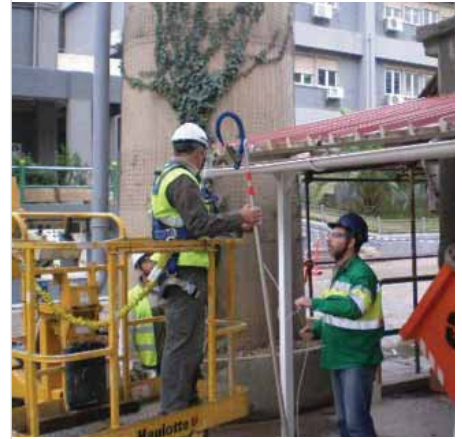
Δραστηριότητες στο εργοστάσιο Χαλκίδας κατά τη διάρκεια της υποδειγματικής εβδομάδας ασφάλειας.
