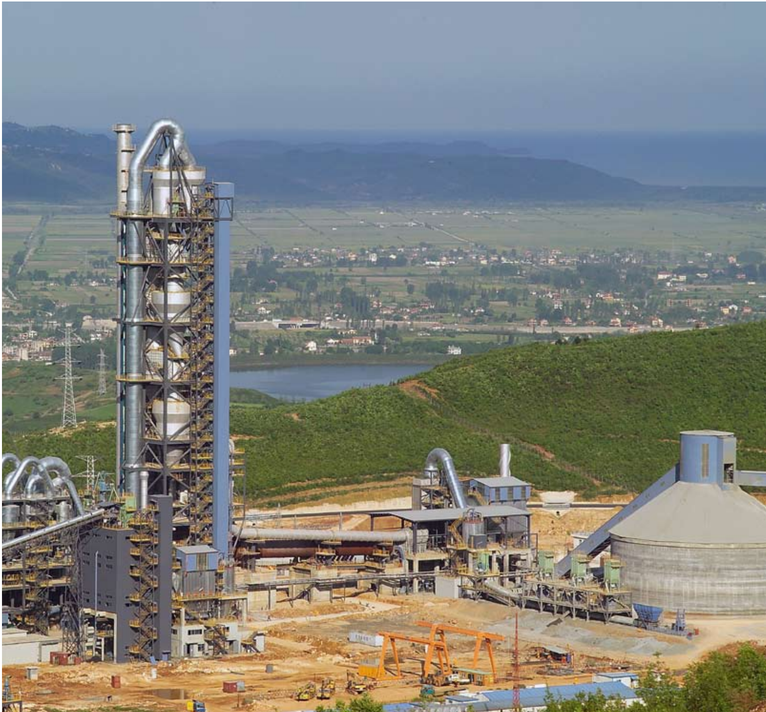
Το νέο εργοστάσιο τσιμέντου του ΤΙΤΑΝΑ στην Αλβανία
