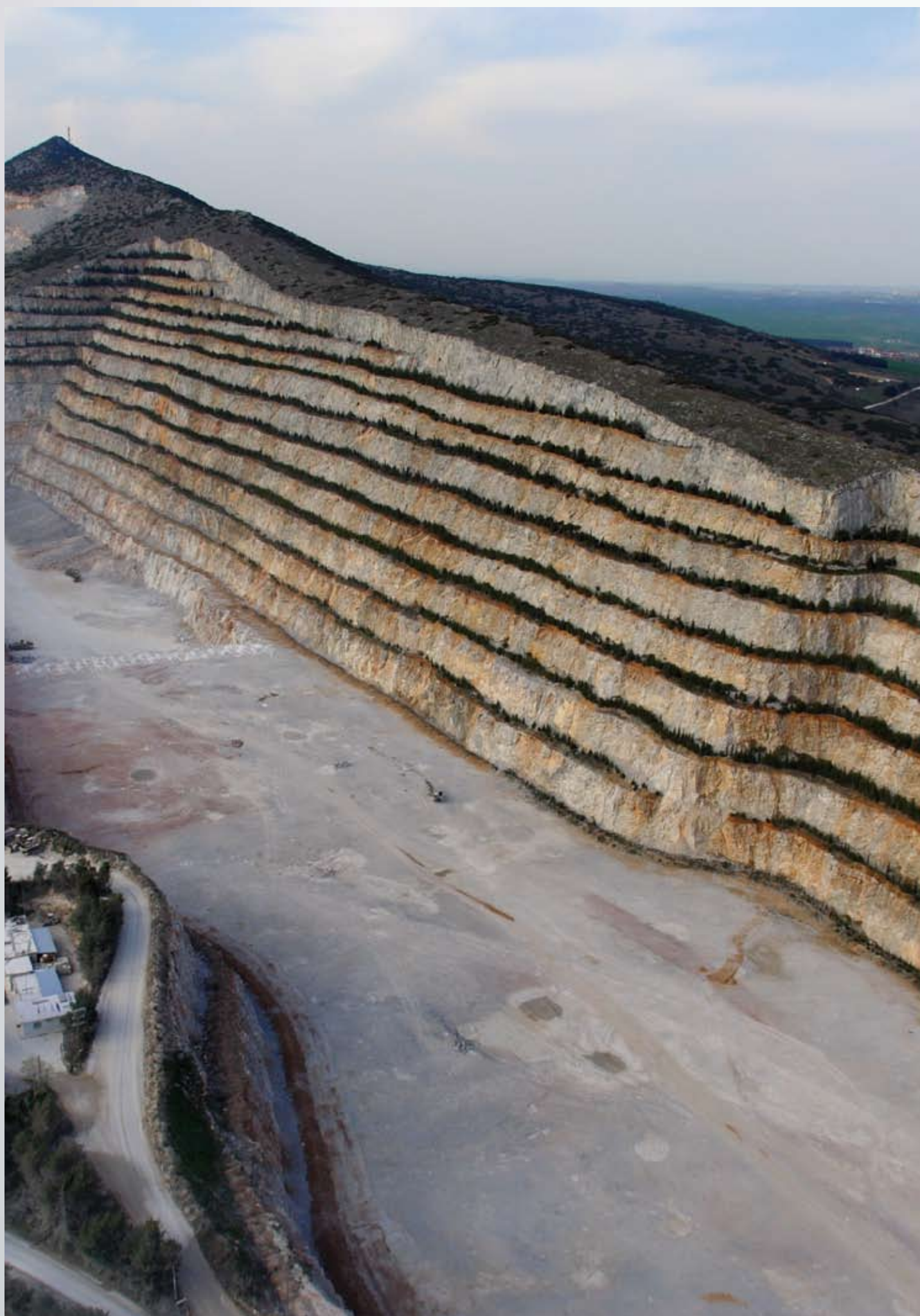
Αποκατάσταση λατομείου Δρυμού, Θεσσαλονίκη
