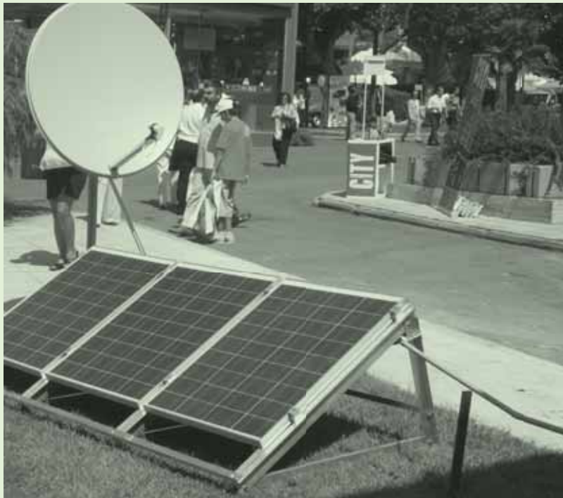
Το φωτοβολταϊκό σύστημα ηλεκτροδότησης του περιπέτρου του ΟΤΕ στην 73η ΔΕΘ.
