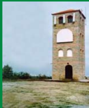
Ειδική κατασκευή Σταθμού Βάσης
