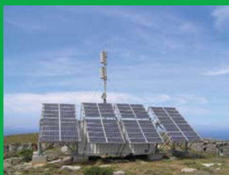
Φωτοβολταϊκό σύστημα σε Σταθμό Βάσης
