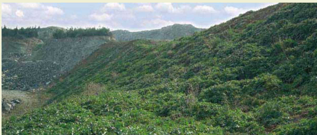
Αποκατάσταση με υδροσπορά, Θεσσαλονίκη, Ελλάδα, 2006
