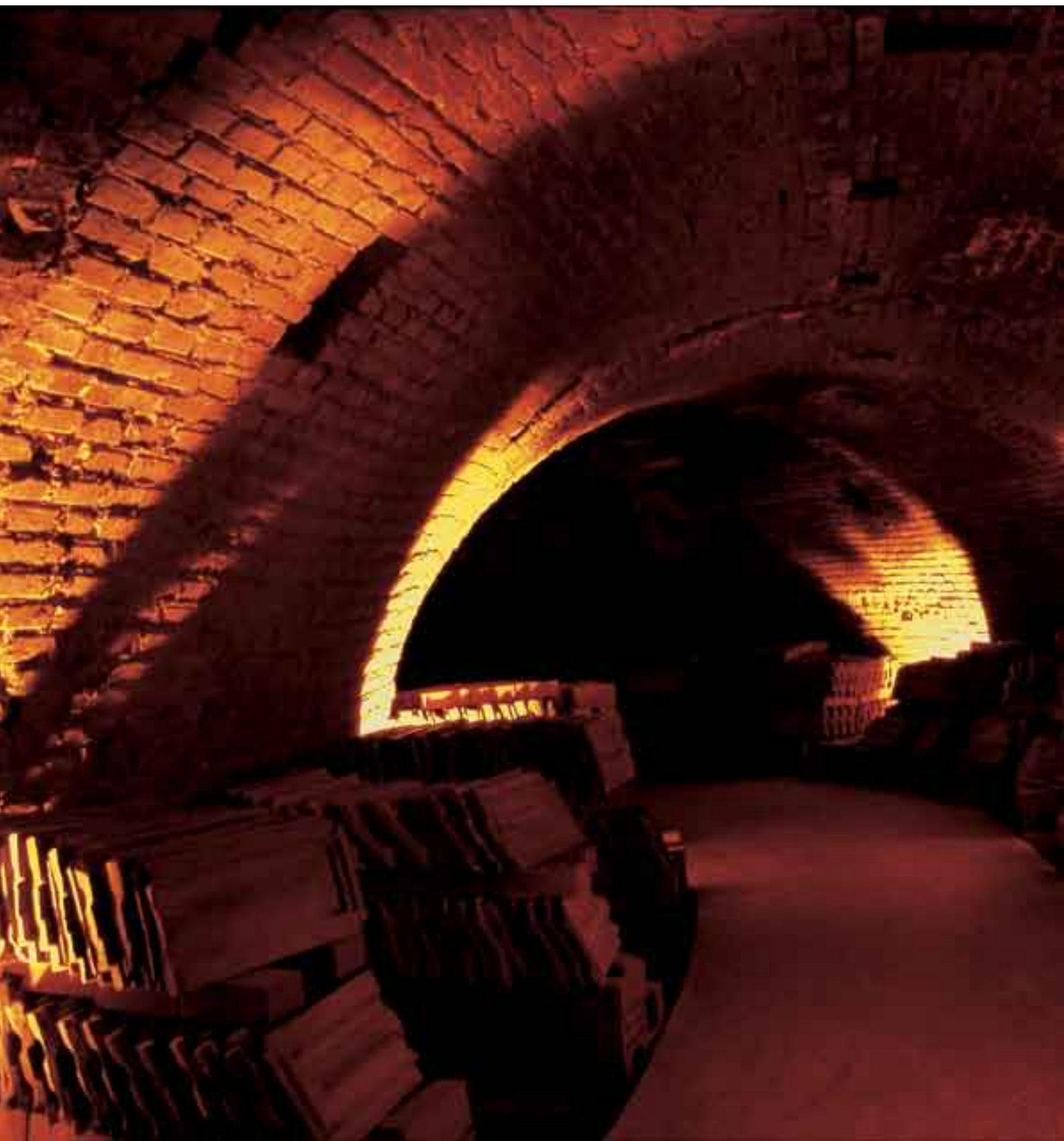
Μουσείο Πλινθοκεραμοποιίας Ν. & Σ. Τσαλαπάτα. Εσωτερική άποψη της καμίνου Hoffmann.
