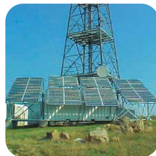
Φωτοβολταϊκό σύστημα σε Σταθμό Βάσης
