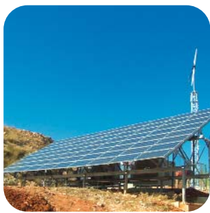
Πιλοτικός «Πράσινος» Σταθμός Βάσης
