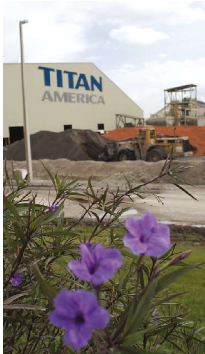
Εργοστάσιο Pennsuco, Φλόριντα - ΗΠΑ
