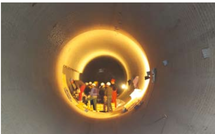
Επισκευή κλιβάνου, εργοστάσιο Καμαρίου - Ελλάδα, 2005
