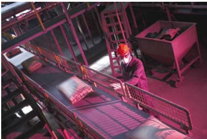
Φόρτωση ενσασκισμένου φαιού τσιμέντου, εργοστάσιο Καμαρίου - Ελλάδα
