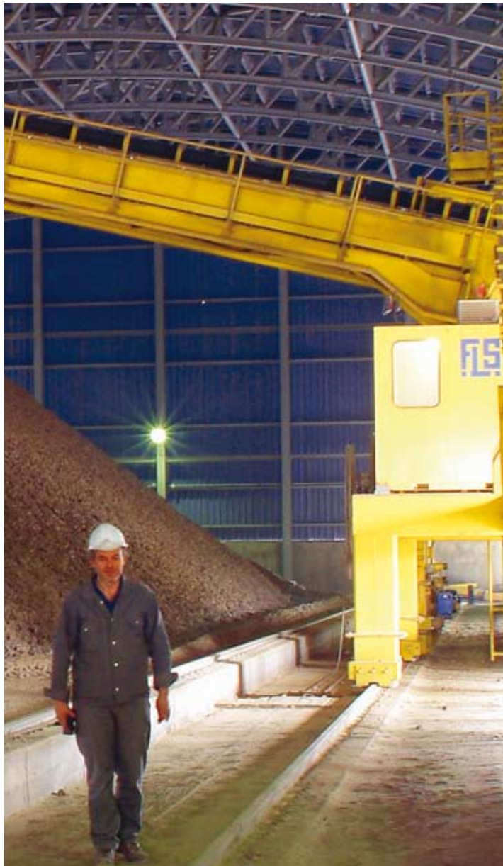
Χώρος προμοιογένειας πρώτων υλών, εργοστάσιο Θεσσαλονίκης - Ελλάδα, 2005
